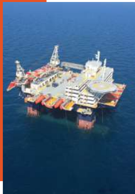
Plataformas de mantenimiento y construcción
